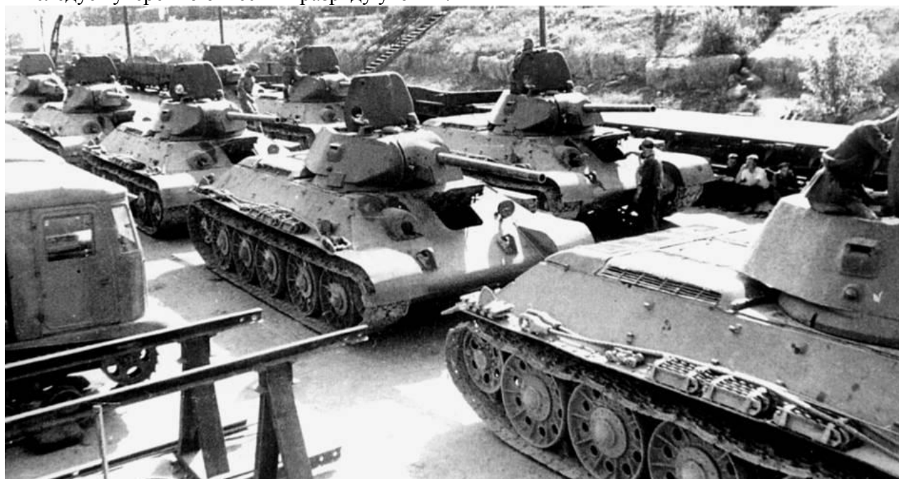
Танки Т-34 и тягачи СТЗ-5 на площадке СТЗ, лето 1942 г. Работающий на полную мощность танковый завод был существенным подспорьем для защитников Сталинграда. Хорошо видны характерные приметы машин военного времени: катки без резиновых бандажей, одна фара, упрощенная маска пушки
