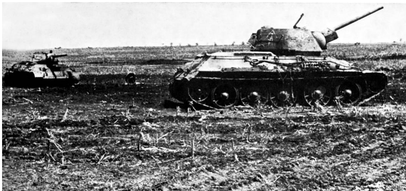
Подбитые под Сталинградом танки Т-34. Машина справа относится к новейшей для осени 1942 г. серии с башней-«гайкой», а слева – постепенно сходившей со сцены версии Т-34 с башней-«пирожком»
