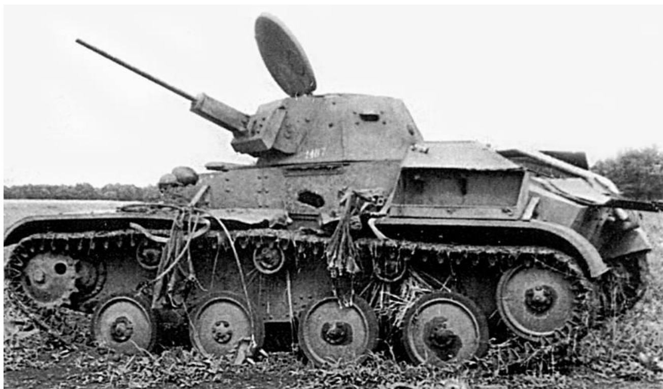
Подбитый в районе Сталинграда танк Т-60. Хорошо видна пробоина в борту корпуса
