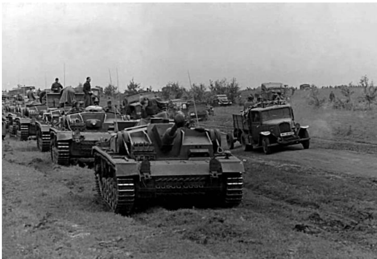
Подразделение штурмовых орудий на марше. Большая излучина Дона. Хорошо видно, что вооружение дивизиона пока смешанное: большая часть САУ вооружена 75-мм короткоствольным орудием. При стрельбе по советским танкам такие самоходки использовали кумулятивные снаряды
